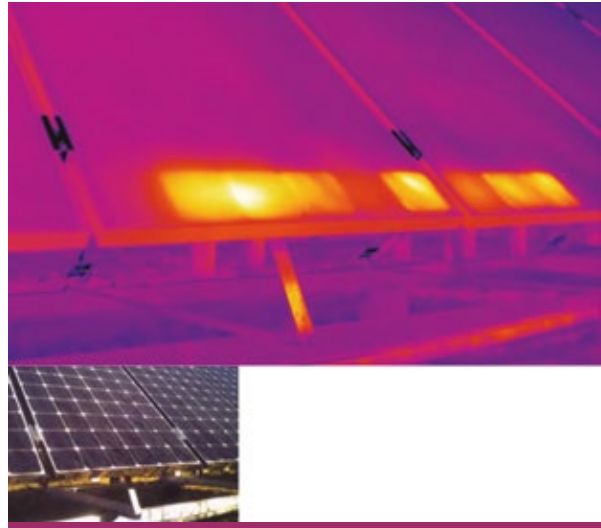
Figura 10. Supervisión y control de instalaciones solares
