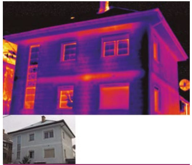
Figura 1. Detección de fallos en la construcción
