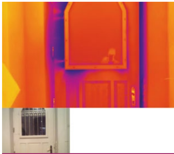
Figura 8. Verificar la hermeticidad de una construcción nueva
