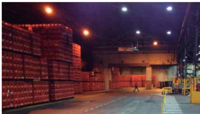
Vista de la instalación piloto con led y sodio de alta presión
