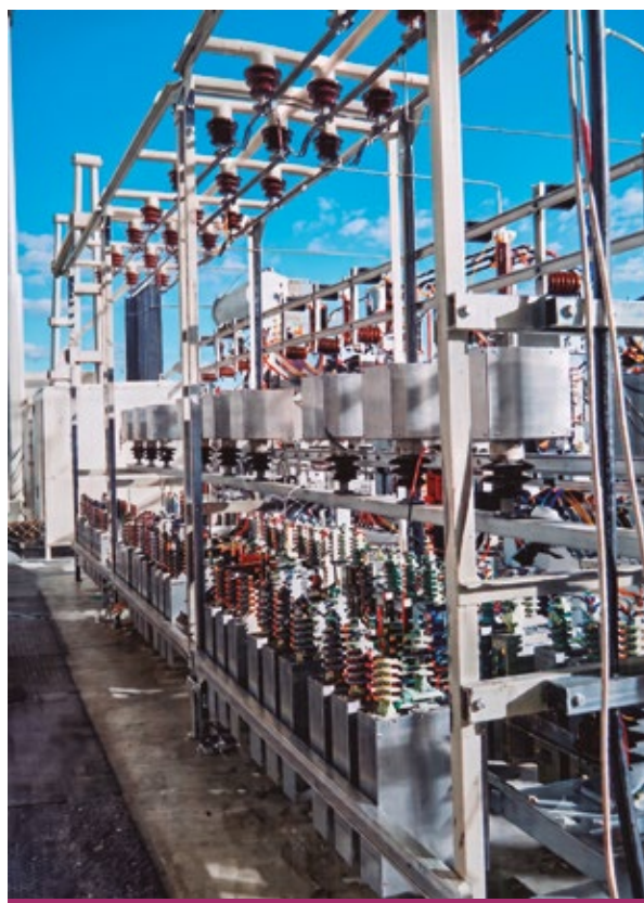
Figura 4. Bancos abiertos automáticos para grandes instalaciones industriales o estaciones transformadoras de media tensión
