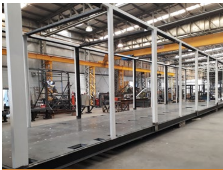
Confección de un shelter de 22 m de longitud
