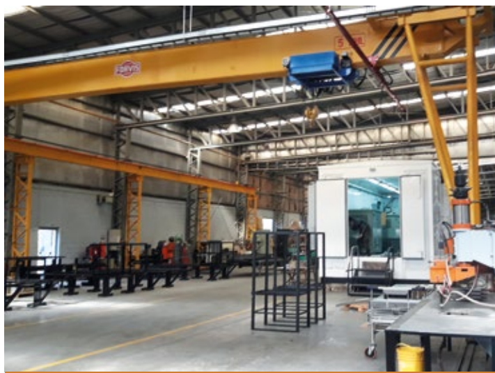
Pórtico de puente grúa
