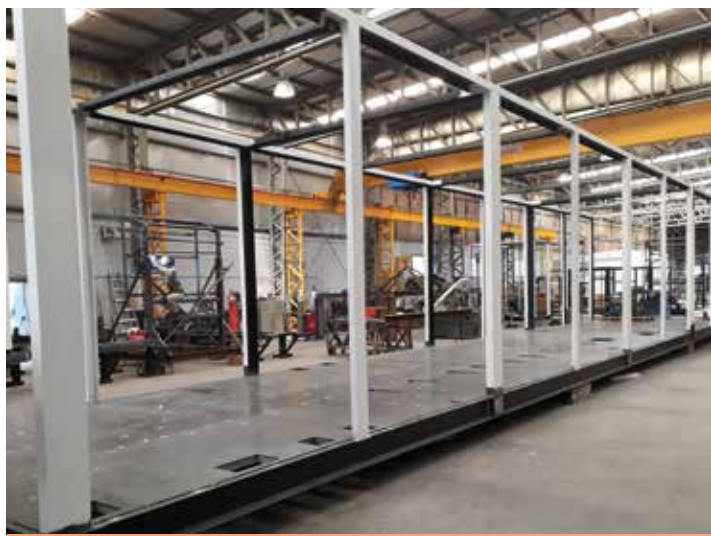
Durante la visita, somos testigos de la confección de un shelter de 22 m de longitud
