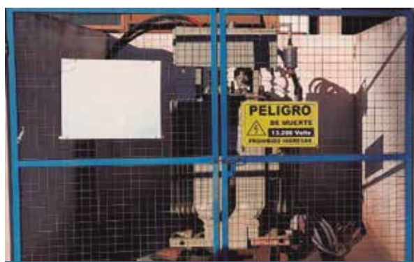
Figura 6. Bornes de baja y media tensión expuestos. Subestación tradicional con menor seguridad.
