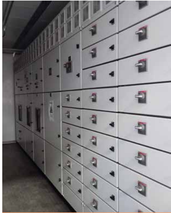
Nöllmed se especializa en tableros protocolizados y a prueba de arco interno
