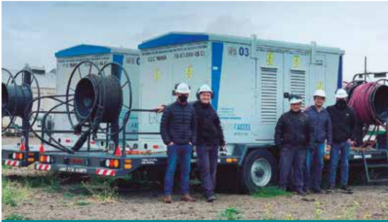
Figura 3. Centro compacto móvil, apto para emergencia y electrificación temporal de redes
