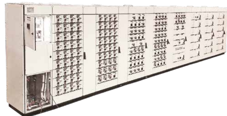
Centro de control de motores. Obra: Planta Piloto Minería Litio en el Altiplano
