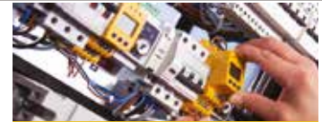
SUPLEMENTO INSTALADORES Pág. 47
