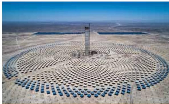
miento térmico en tanques, lo que aporta una gran flexibilidad al sistema eléctrico. Las sales se mantienen a una temperatura de 560 °C en el caso de los tanques de sales calientes, y a 290 °C en el caso de tanques de sales frías.
