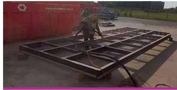
Figura 4. Tratamiento del bastidor de piso
