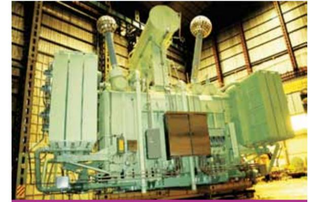
También los terminales y aisladores de salida de este arrollamiento elevan su clase de aislación. Dado que pueden trabajar continuamente con 132 kV plenos respecto de tierra, no pueden valerse de un descargador de sobretensión de 145 kV, porque entonces la tensión de operación estaría por debajo de lo requerido.
