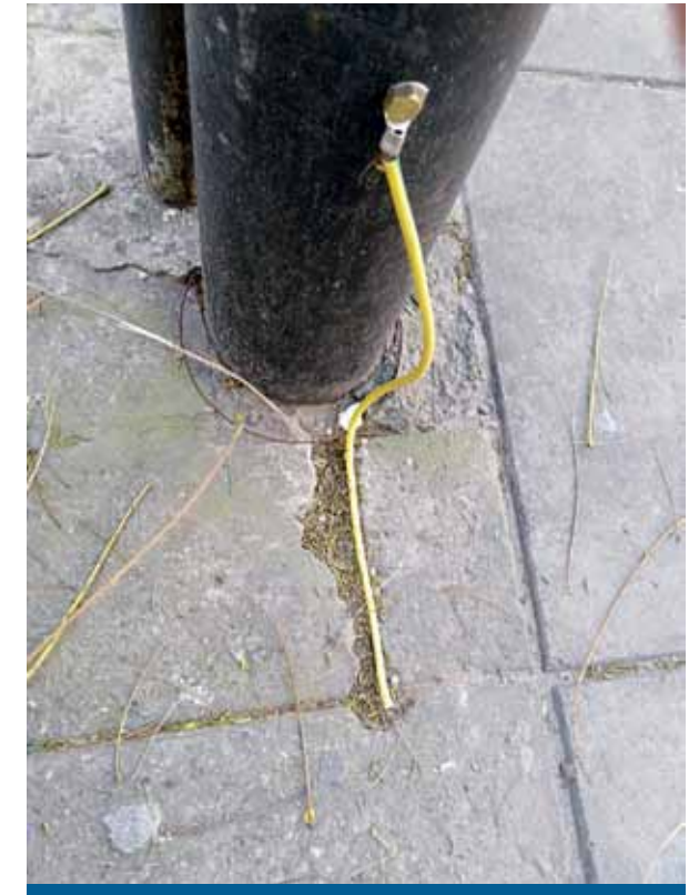
Conexión de puesta a tierra muy expuesta sobre columna de iluminación
