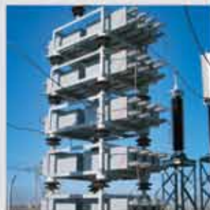
Banco derivación 132kV Transener - ET B.Blanca
