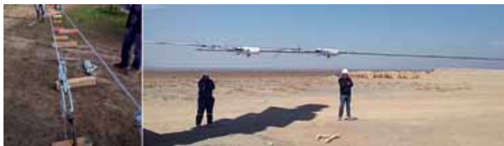
Figura 16. Ensayo in-situ de ranas para verificar capacidad de amarre al tensado especificado
