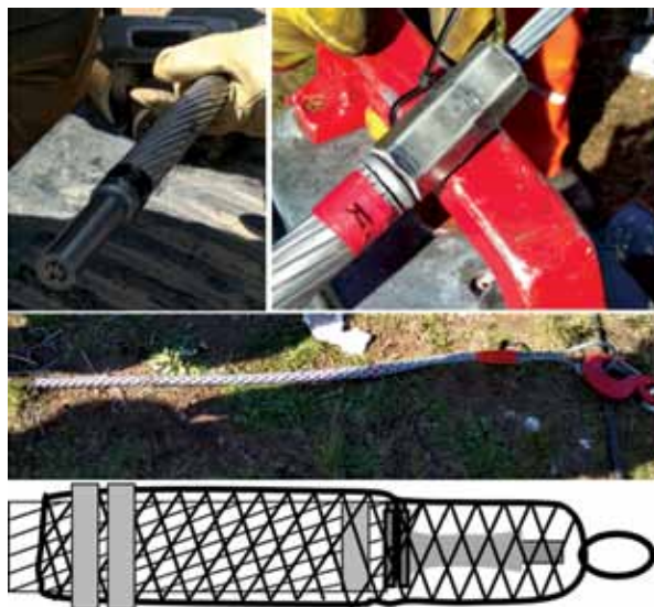
Figura 12. Armado del conjunto especial para la media de tiro y esquema asociado
