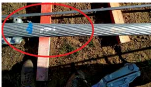
Figura 18. Daños por no emplear ranas en tándem
