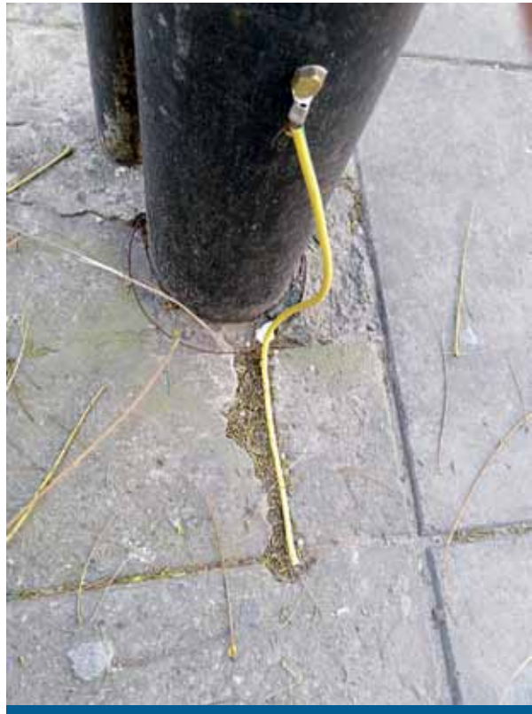
Conexión de puesta a tierra muy expuesta sobre columna de iluminación
