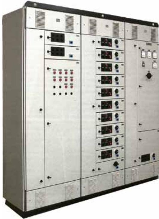
Figura 5. Tablero tipo CCM
