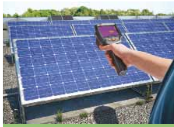
Figura 3. Aseguramiento de la eficiencia de parques solares con cámaras termográficas
