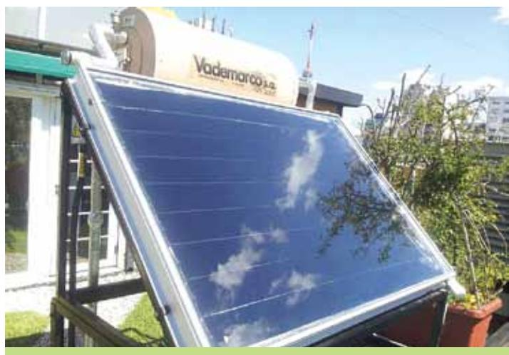
Los tanques están contruidos con acero inoxidable de excelente calidad y tapas toriesféricas que garantizan un rango seguro de operación, con cubierta de poliuretano expandido de alta densidad de cincuenta milímetros (50 mm) como protección térmica. Pueden ser provistos en versiones de circulación abierta o cerrada, en la cual el agua de la red no circula por los paneles captadores, eliminado los peligros que originan la cal y las heladas.
