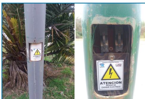
La protección eléctrica y la conexión entre el neutro, la masa eléctrica y la toma de tierra deberían ubicarse en el interior de la luminaria dado que en la explotación siempre se debe acceder a ella. Se reducen así los tiempos de intervención y se mejora su condición de conservación.
