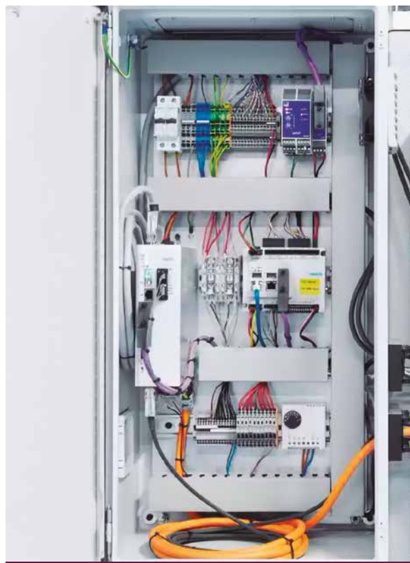
Todo bajo control en el conjunto de servoprensas YJKP: controlador CECC-X y controlador del motor CMM, inclusive software de aplicación.
