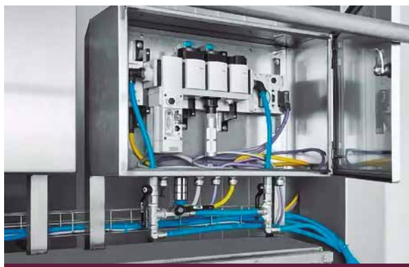
La primera generación del módulo de eficiencia energética MSE6-E2M funciona sin interrupciones en la planta de Unilever. El módulo que se ofrece actualmente en el mercado es un 50 por ciento más compacto.
