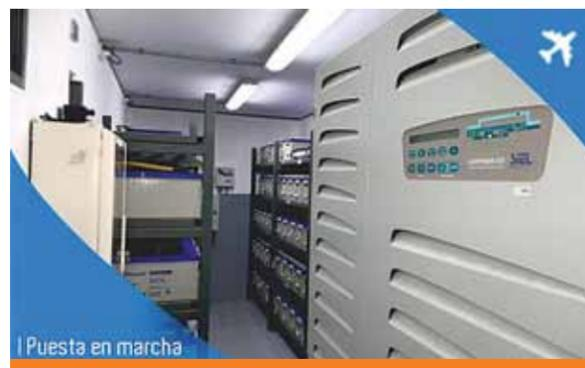
Ocurre que la solución provista, el UPS Safe Power Evo, es un UPS de tipo industrial en el que se priorizó absolutamente la confiabilidad, consta de transformador a la salida que le da a la carga aislamiento galvánico, y un marcado sobredimensionamiento en sus semiconductores, elementos magnéticos, filtros capacitivos, con criterios de redundancia en sus fuentes de alimentación y sin puntos únicos de falla en su hardware. Además cada módulo del equipo tiene su control electrónico único.
