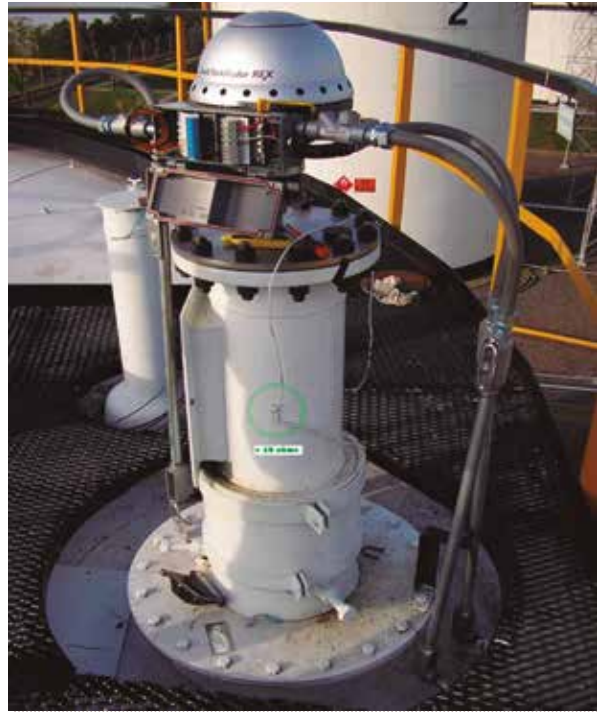
Radar con antena para caño guía
