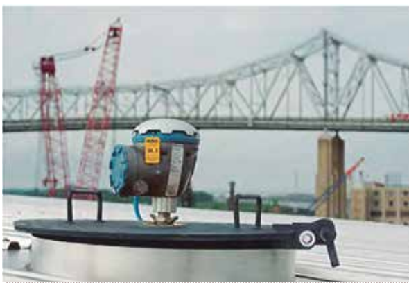
Moderno radar instalado en boca de hombre, tanque de techo fijo
