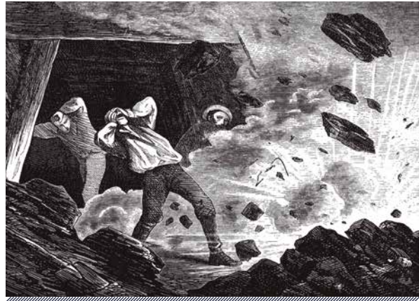
Figura 2. Las condiciones de trabajo eran extremadamente peligrosas en las minas de carbón durante la primera mitad del siglo XIX, debido a la potencialidad explosiva de los ambientes.
