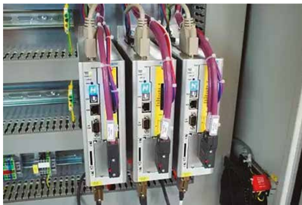
Los controladores de tipo CMMP con un módulo de seguridad integrado controlan los sistemas de manipulación en las áreas de aplicación de pasta térmica y remachado en caliente.
