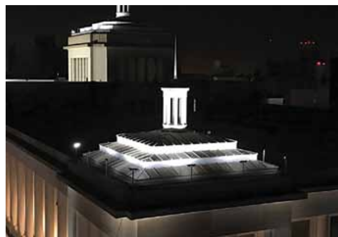
Figura 8. Detalle de chapitel y linterna esquinera vista desde edificio de enfrente
