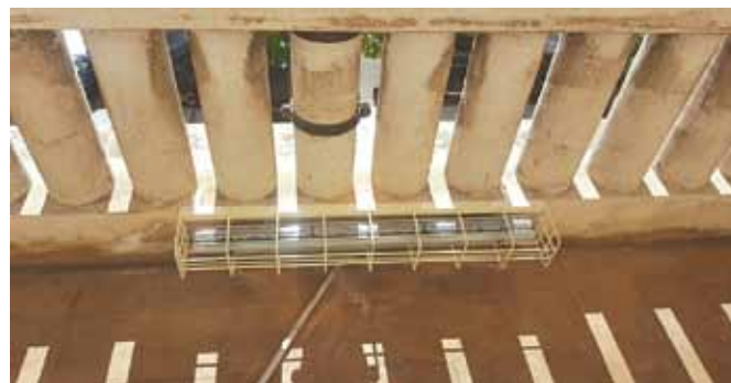
Figura 11. Protecciones antivandálicas en luminarias ubicadas en los balcones tras las balaustradas
