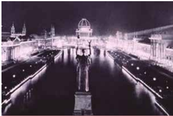
Figura 3. William Henry Merrill, un joven electricista, fue contratado en 1893 para realizar la verificación de seguridad de la extensa instalación eléctrica de la Feria Mundial, presentada en Chicago durante ese mismo año
