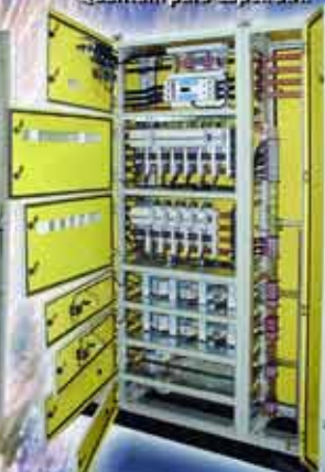
CENTRO DE CONTROL DE MOTORES Quantum para Capex S.A.
