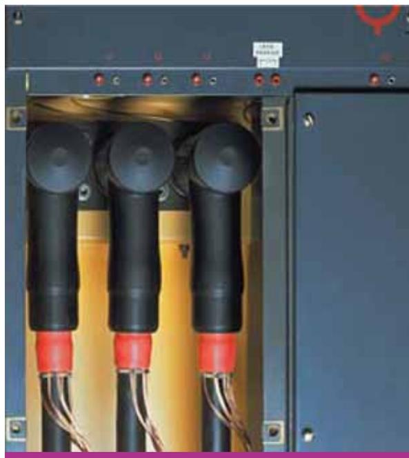
DIN. Su diseño compacto permite el uso de conexiones doble T dentro de compartimentos reducidos. Se requieren pocos accesorios para el sistema de testeo, conexión de doble T y puesta a tierra.
