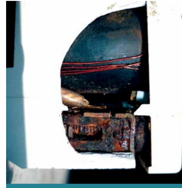
Detalle del borne dañado
