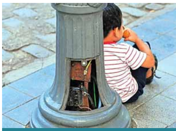
Riesgo máximo. Los cables y la bornera de la columna "al aire" y a centímetros de un chico (foto Sergio Cejas)
