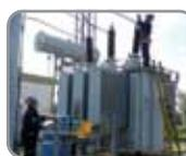
Estado de la condición mecánica de los transformadores mediante Respuesta de Frecuencia de Barrido (FRA/SFRA)
