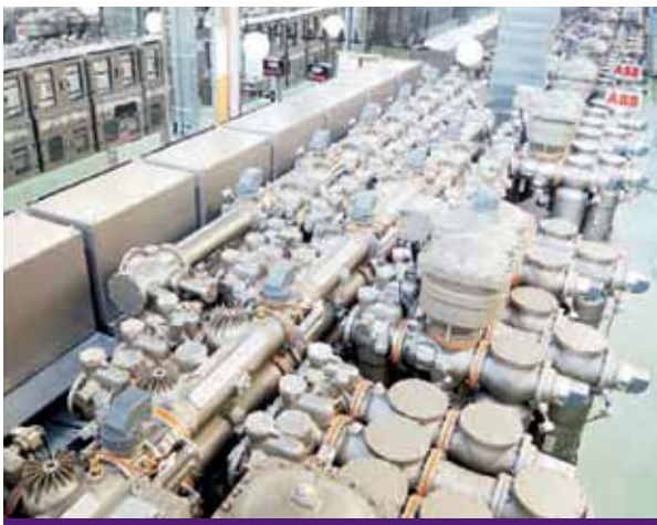
Figura 4. GIS con la nueva mezcla de gases instaladas en Zúrich. a) GIS de alta tensión, 170 kilovolts; b) GIS de media tensión, 24 kilovolts
