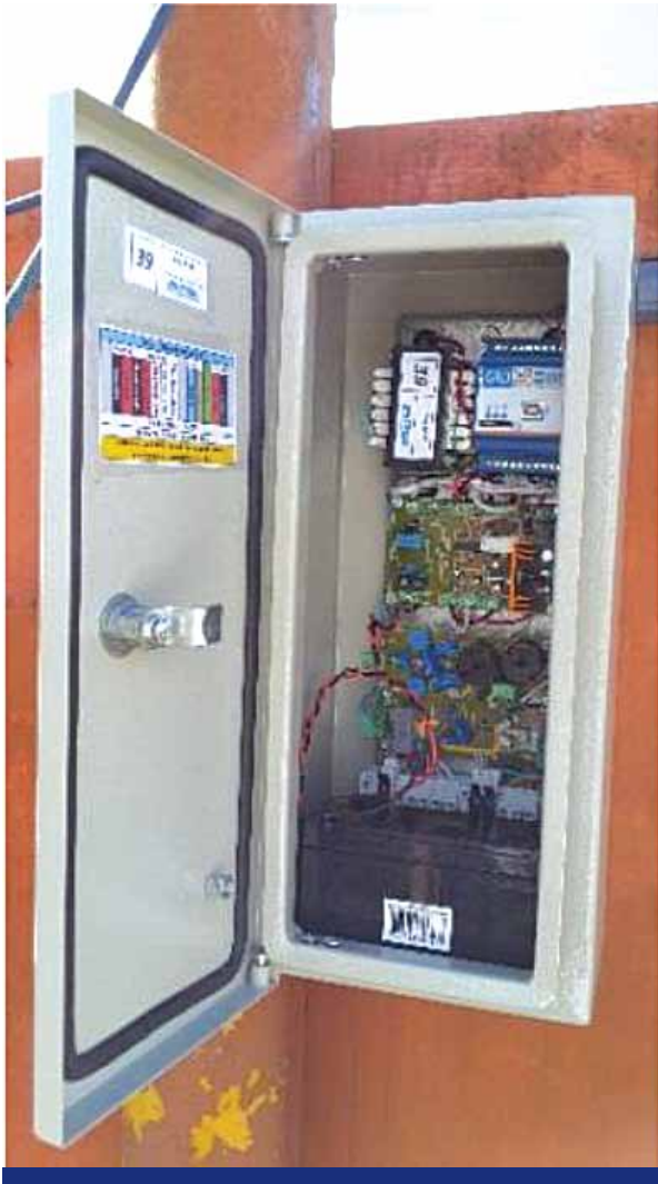
Figura 13. Circuito impreso instalado en campo
