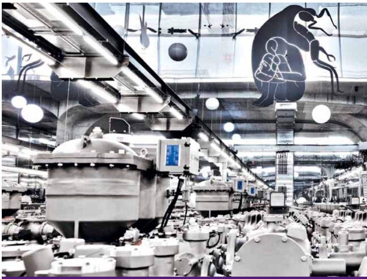
Figura 1. El hexafluoruro de azufre ha demostrado su eficacia como medio de aislamiento para aparata eléctrica, pero preocupa su contribución al calentamiento global. ABB ha desarrollado una alternativa que, en algunos casos, tienen el mismo rendimiento que el hexafluoruro de azufre. La imagen ilustra GIS de alta tensión.
