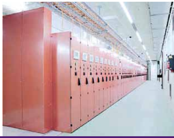
Figura 4. GIS con la nueva mezcla de gases instaladas en Zúrich. a) GIS de alta tensión, 170 kilovolts; b) GIS de media tensión, 24 kilovolts
