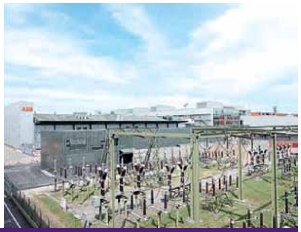
Figura 6. Subestación de EWZ de Zúrich: la primera instalación de aparata piloto con la mezcla de gases que sustituye al hexafluoro de azufre. a) El edificio de la subestación de Oerlikon; b) la fábrica de GIS alta tensión de ABB se ve detrás de la subestación.
