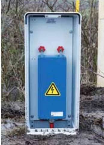
Instalación en envoltorio exterior.
