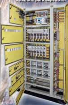
CENTRO DE CONTROL DE MOTORES Quantum para Capex S.A.
