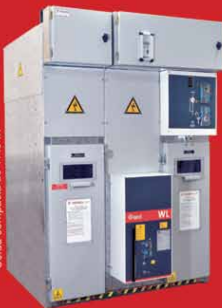
Celda compacta de 17.5 kV
