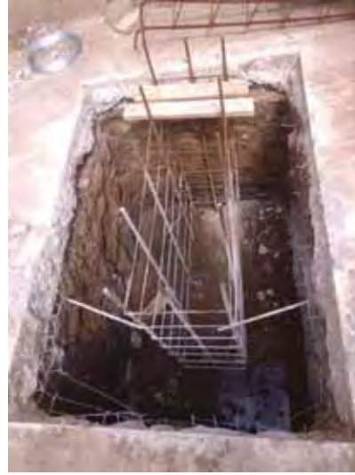
Armaduras de bases de hormigón armado (tomos de tierra de cimientos).
