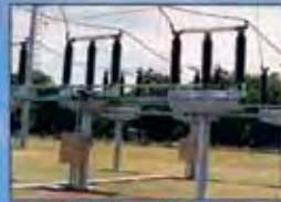
Seccionadores de alta tensión
