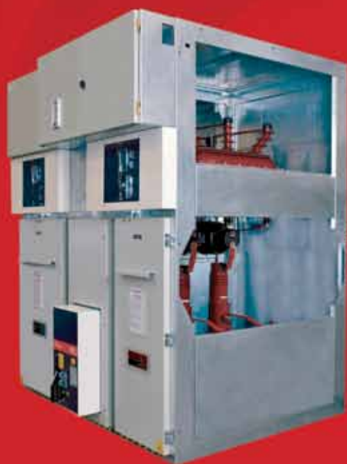
Celda compacta de 36 kV
