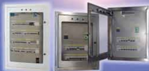
GABINETES DOMICILIARIOS - Hostels Tipitike (S.M.Andes)
