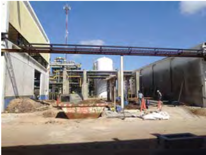
Personal de Á. Reyna & Asoc. realizando este tipo de procedimientos en una industria electroquímica.
