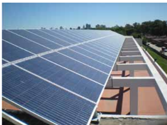
Fig. 7: Instalación FV en la Facultad de Informática de la UNLP.
