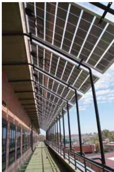
Fig. 6: Instalación FV de 4,6 kW en una pérgola del tercer piso del edificio Tandar.
