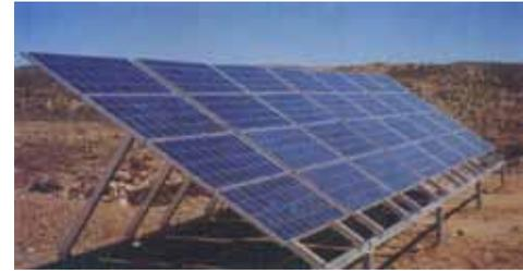
licio policristalino de alto rendimiento, conectadas en serie. Este tipo de generadores entrega un voltaje superior al de los módulos autorregulados. Con estos generadores es imprescindible utilizar un regulador de carga de baterías para impedir su sobrecarga. El regulador de carga puede a su vez proteger a las baterías contra una sobredescarga por un alto consumo en relación a la generación.
