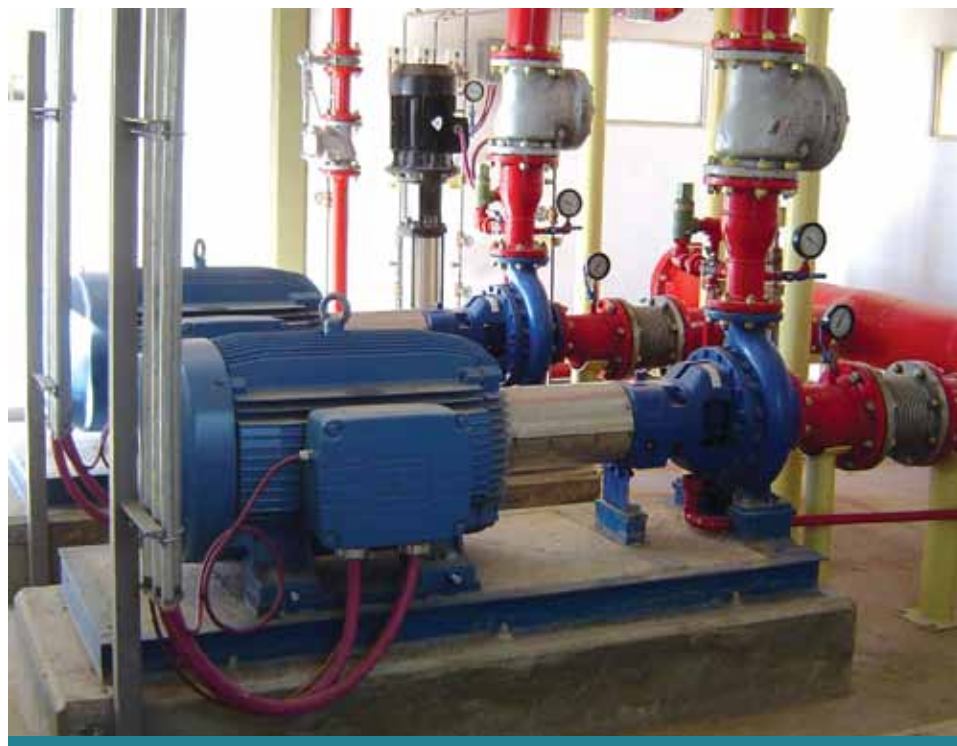
Figura 2. Conjunto motor eléctrico y bomba
